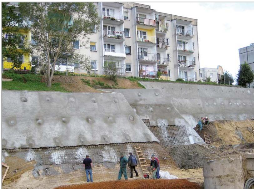
**Confortement de surface à l'aide de béton projeté armé**
