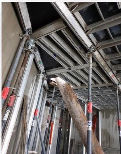
Étais de coffrage autour de butons
