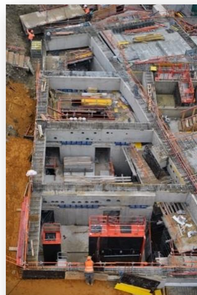
Un chantier sécurisé
