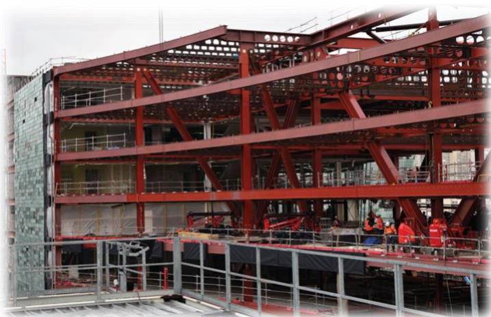
Chantier du Siège du Groupe Le Monde : 7 étages à construire
