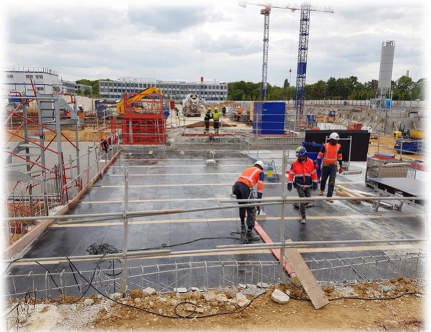
Solution de dalles coulées en place
