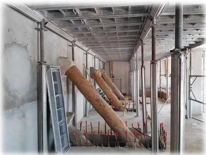
Étais de coffrage autour de buttons
