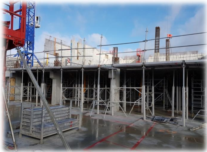
Phase 2 de la construction d'Agro Paris Tech
