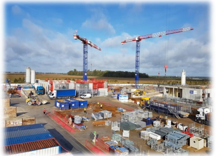
Vue d'ensemble du chantier AgroParisTech
